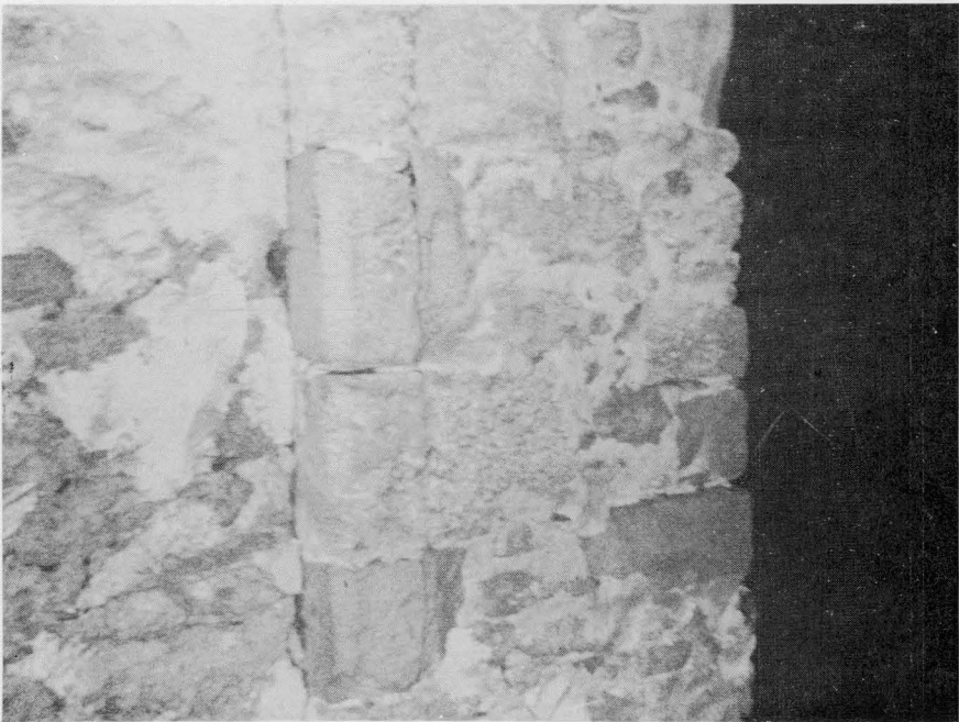
La Grange aux Moines. — Vestige de pilier dans ce bâtiment.
